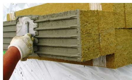
Lepenie minerálnovláknitých lamiel. Celoplošné lepenie pomocou hrebeňa (FKL).
