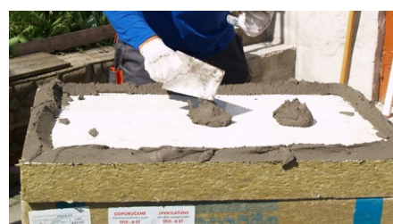
SMARTwall S C2 nie je potrebné penetrovat ani z jednej strany.
