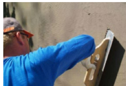
Vyhľadanie výstužnej vrstvy, prípadne nanosenie doplnkovej tenkej vyrovnávacej vrstvy.
