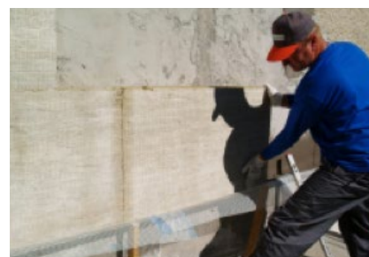
Prilepenie na stenu na zraz, bez škár.
