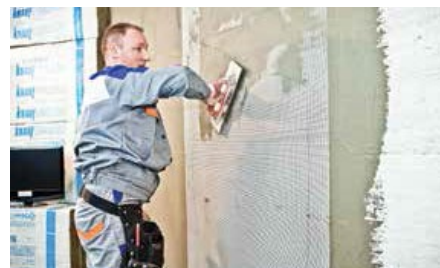
Doska s nástrekom ihneď pripravená na naniesenie výstužnej vrstvy.
