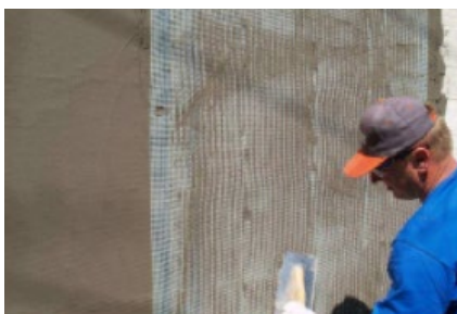
Apolikuje sa sklotextilová výstužná mriežka - hlavná armovacia vrstva.
